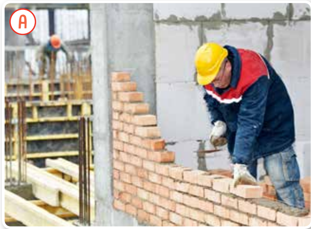
Albañil construyendo un muro.
