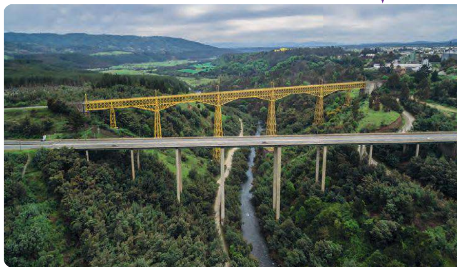
» Viaducto del Malleco en la actualidad.
