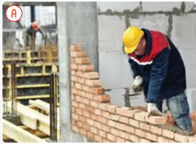
Albañil construyendo un muro.
